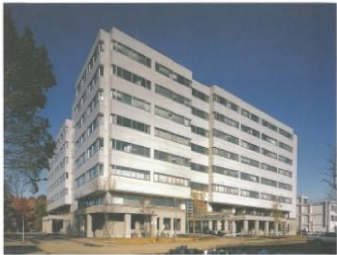
材料・化学棟 (南西より)
