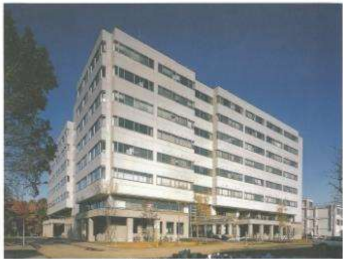
材料・化学棟（南西より）
